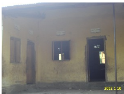
Eingang zum Kindergarten
